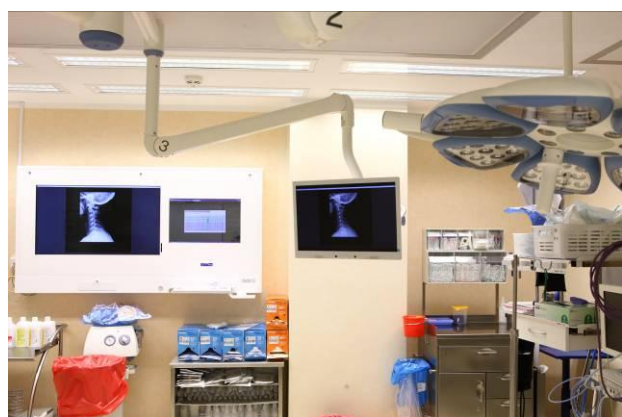
DiCO 2M 40"/24" do powieszenia na ścianie + monitor 24" przy polu operacyjnym
