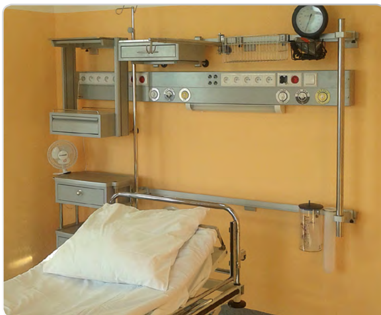
Kaseton elektryczno-gazowy ISA 9000 naścienny w układzie poziomym z wyposażeniem szynowym systemu ISA
